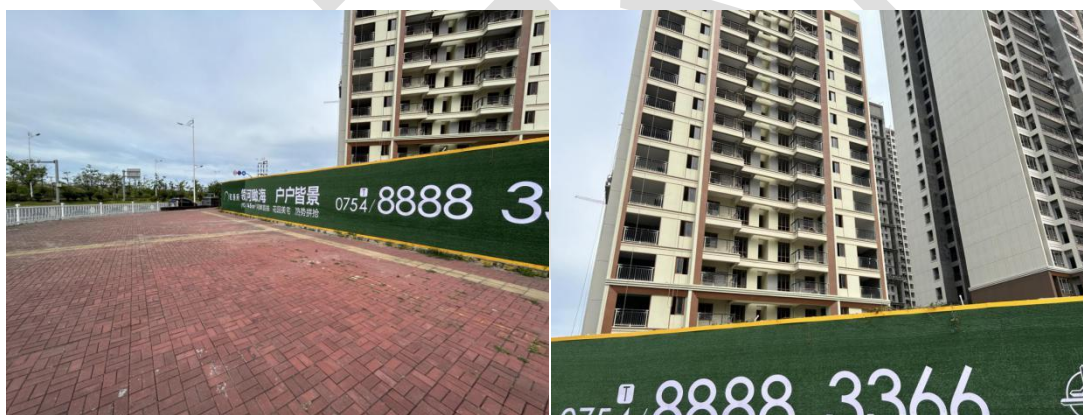
图 4.2.4-2 接收井所在区域现状
