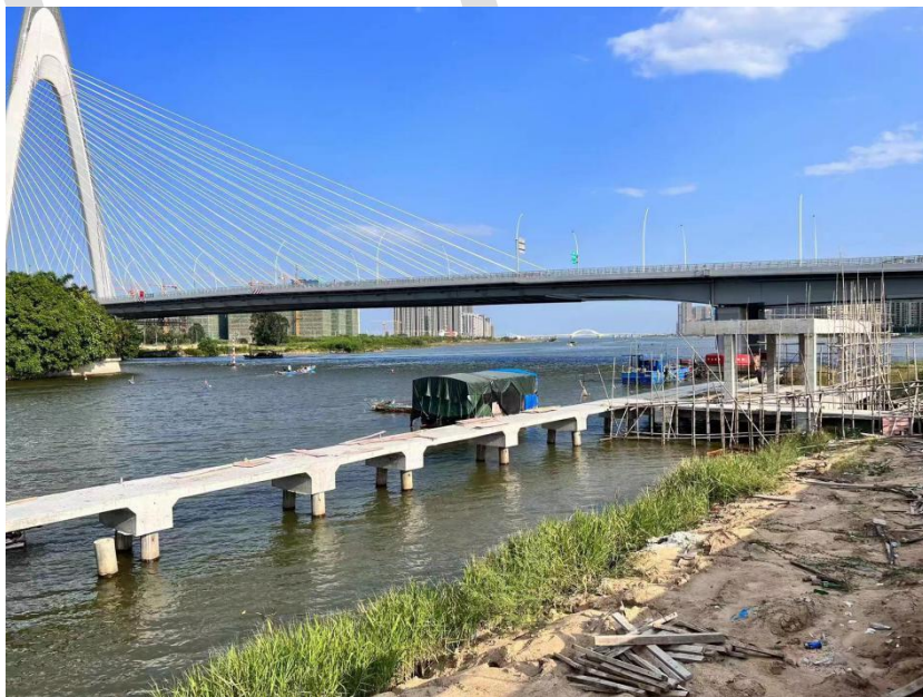
图 4.1.2-1b 汕头市中山东路东延新津河大桥工程（中津大桥）
