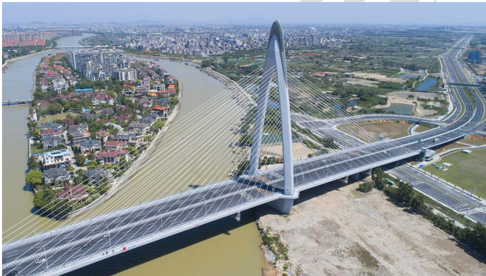
图 4.1.2-1a 汕头市中山东路东延新津河大桥工程（中津大桥）
