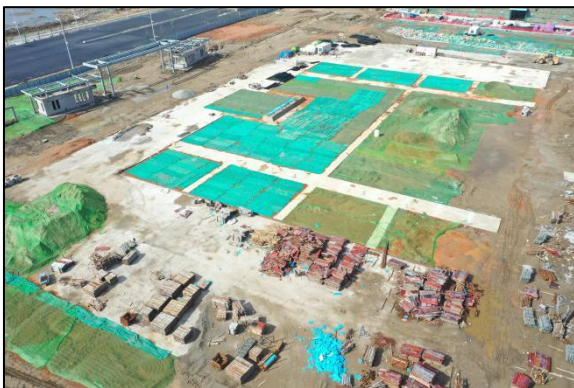
土工布覆盖措施图 4-7
