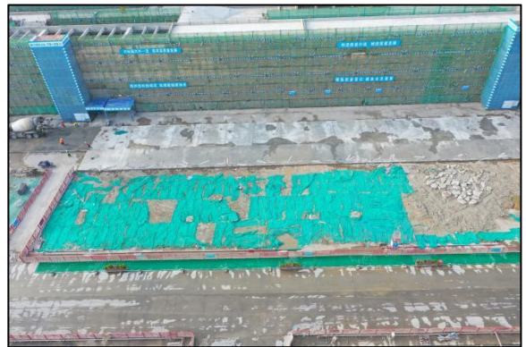
土工布覆盖措施图 4-8
