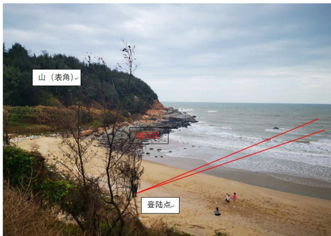
图 2.2.6-5 已完成铺设的登陆点附近岸线情况
