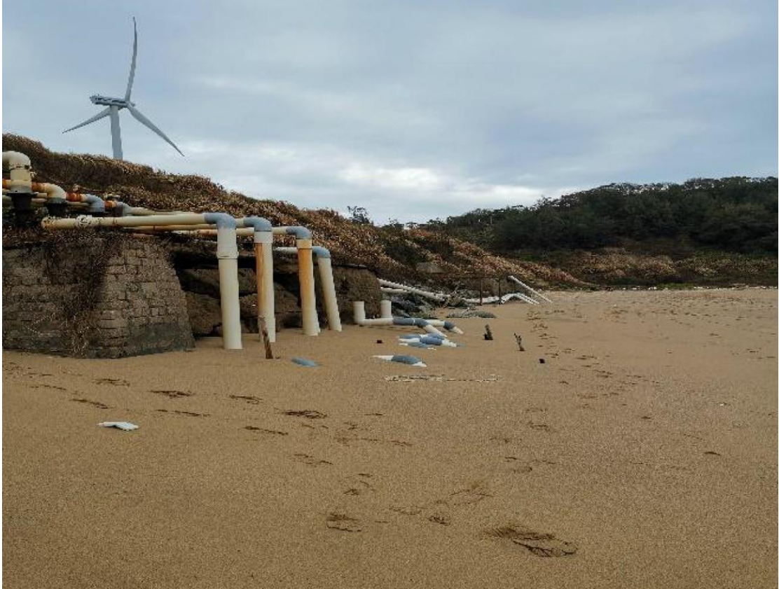
b 登陆点西南侧的废弃输水管道
