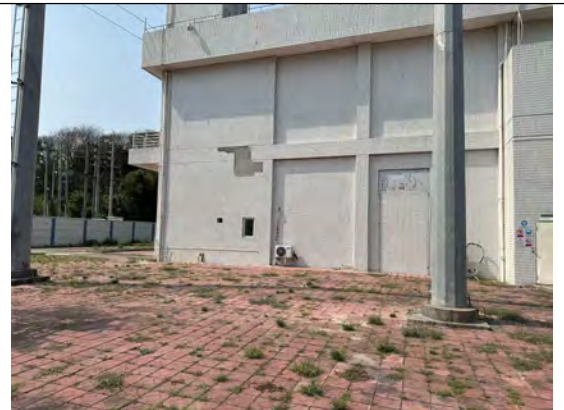
拟扩建 3#主变基础
