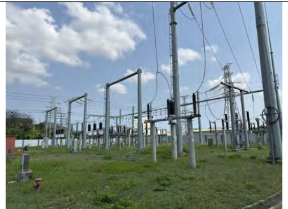
110kV 出线架构
