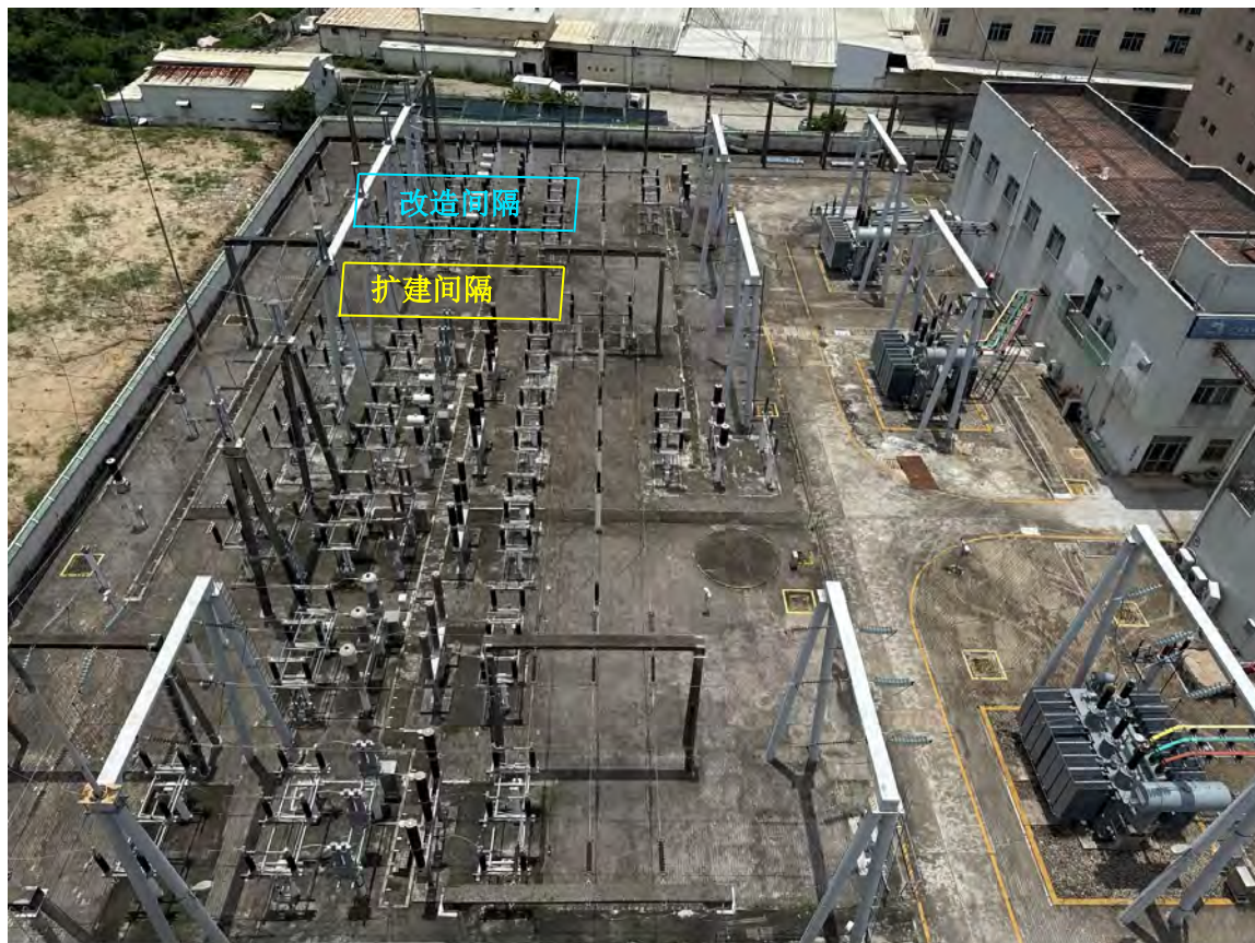
图 2.5-1 110 千伏上堡站扩建及改造间隔位置
