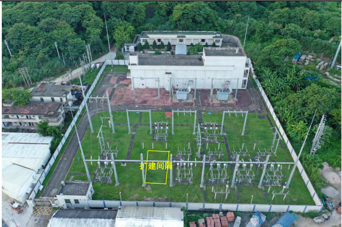
图 2.5-2 110 千伏铜孟站扩建间隔位置
