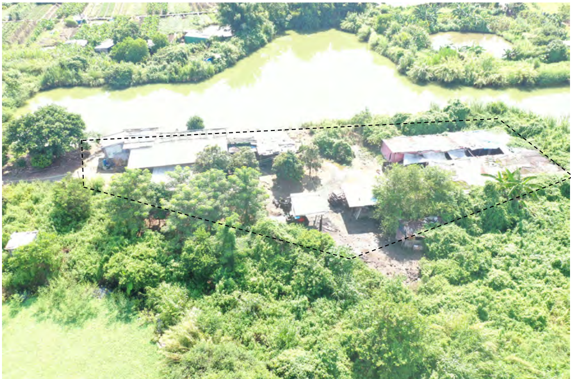
图 2.4-1 本项目拟拆迁新建大亨站东侧 110kV 进出线位置棚房
