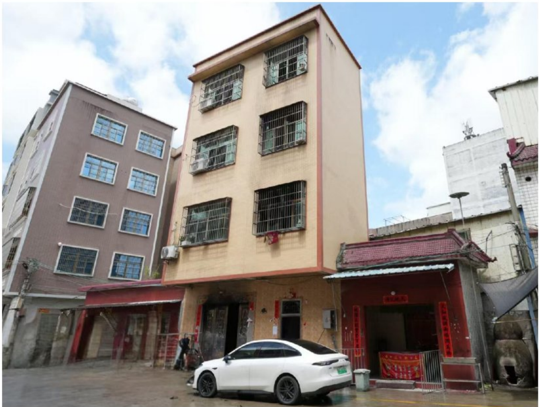
图 1-2 起火建筑概貌
