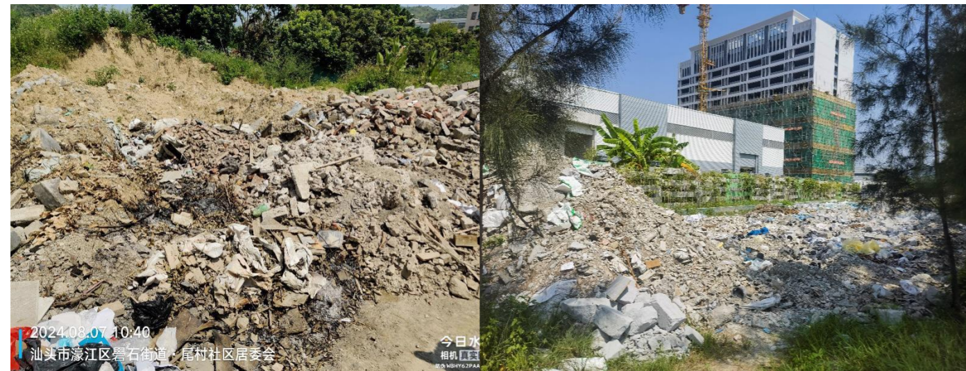
c) 临时堆放点未采取必要的覆盖措施
