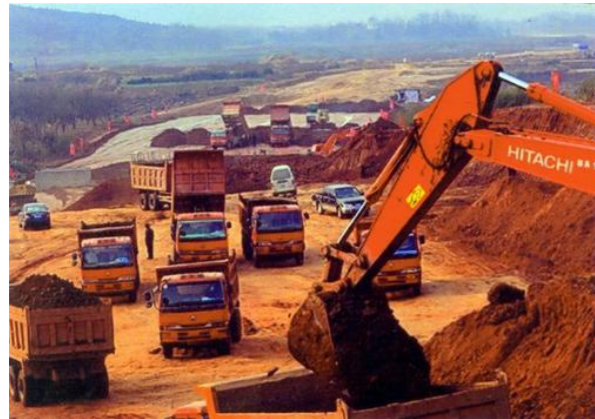
a) 工程渣土
