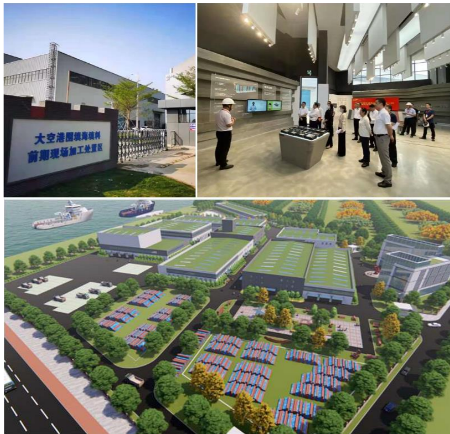
图 3-6 深圳大空港建筑垃圾处理项目
