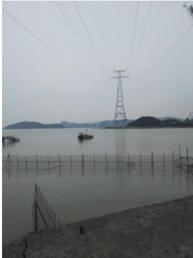
图 3.4.2-3 架空电缆现场图
