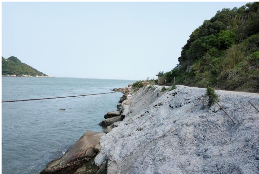
图 3.4.2-12 拟建隧道工程上游堤防（右岸濠江侧，向下游拍摄）
