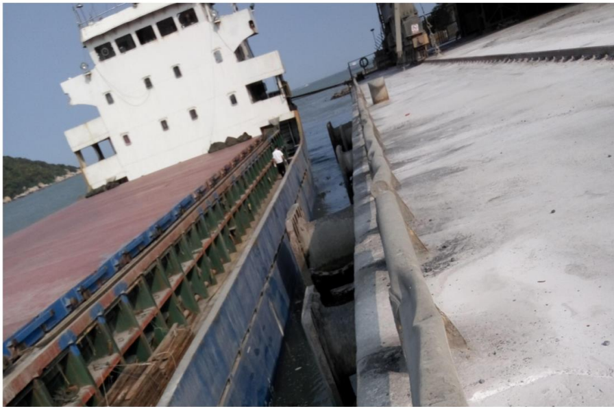
图 3.4.2-5 拟建隧道工程上游 100m 处华润水泥公司码头（右岸濠江侧）
