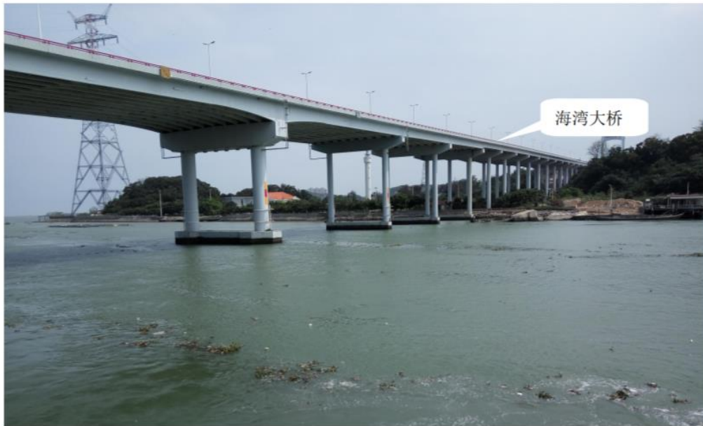
图 3.4.2-1 拟建隧道工程上游海湾大桥（左岸龙湖侧）
