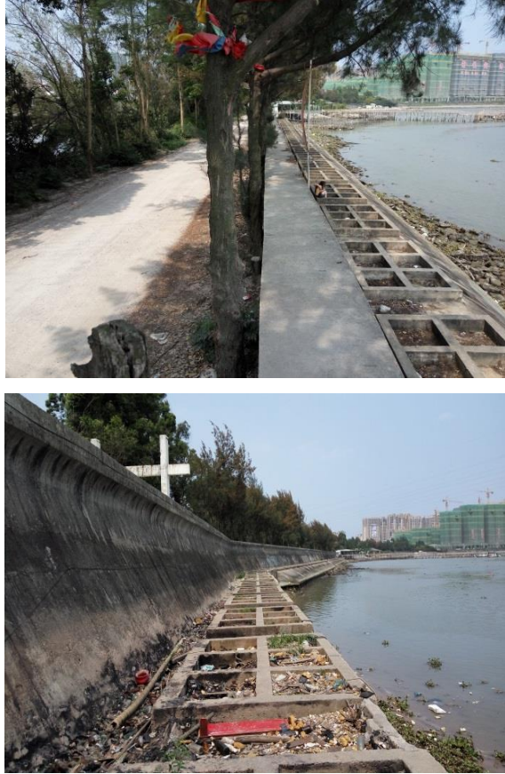
图 3.4.2-11 拟建隧道工程上游堤防（左岸龙湖侧，分别向上、下游拍摄）
