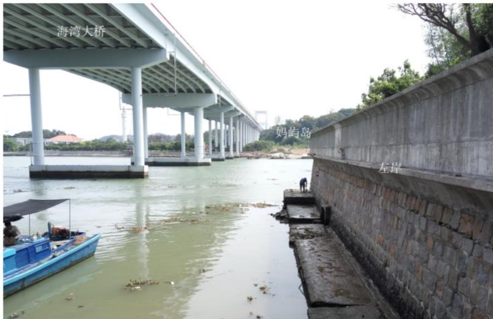
图 3.4.2-2 拟建隧道工程上游海湾大桥（左岸）
