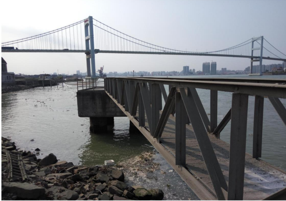
图 3.4.2-4 拟建隧道工程上游 100m 处华润水泥公司码头（右岸濠江侧）
