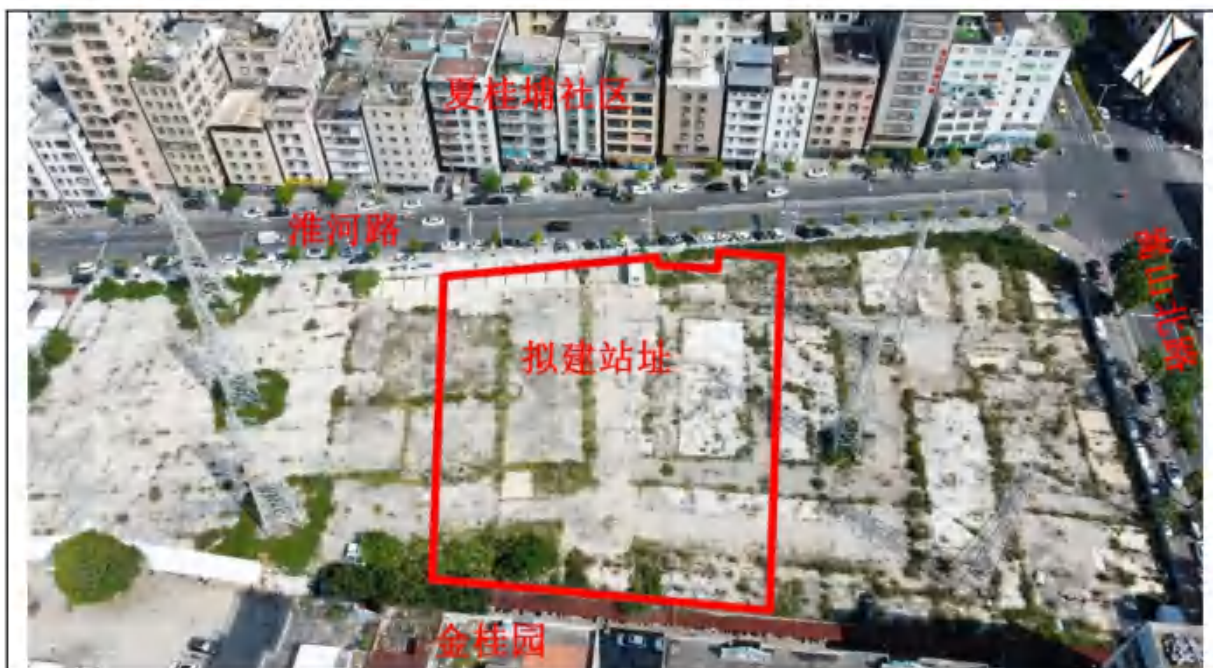
拟建站址现状
