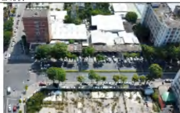
拟建站址西南侧现状
