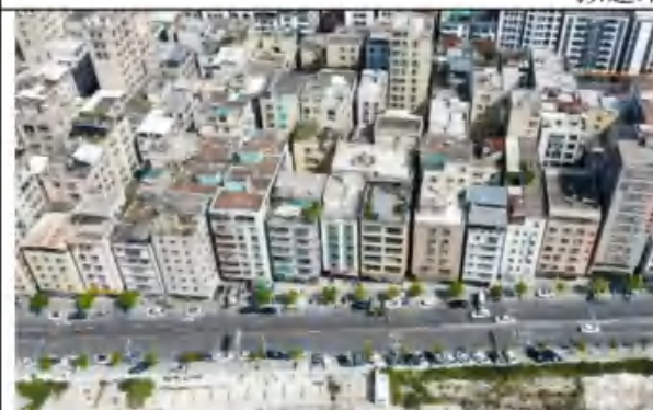
拟建站址东南侧现状
