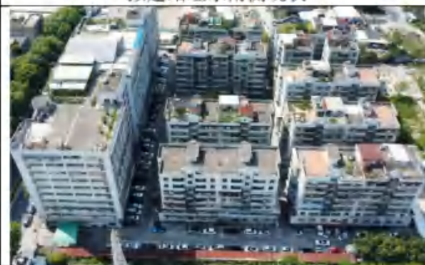
拟建站址西北侧现状
