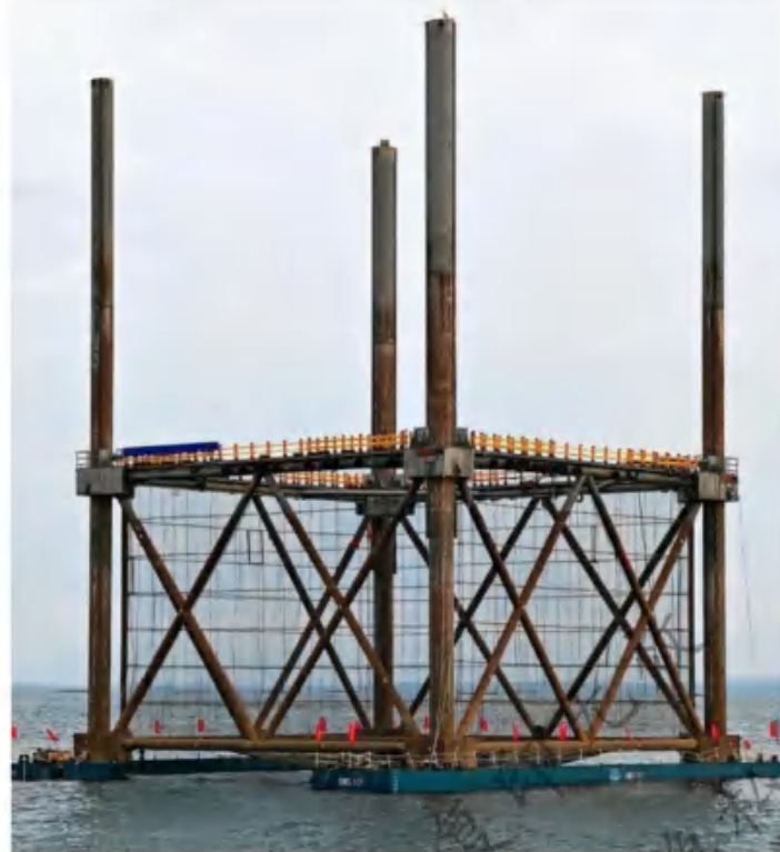
图 1.5.2-3 自升式桁架类网箱
