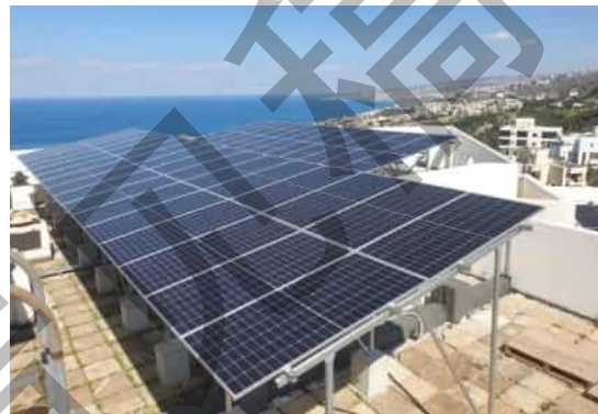
加装屋顶太阳能板
