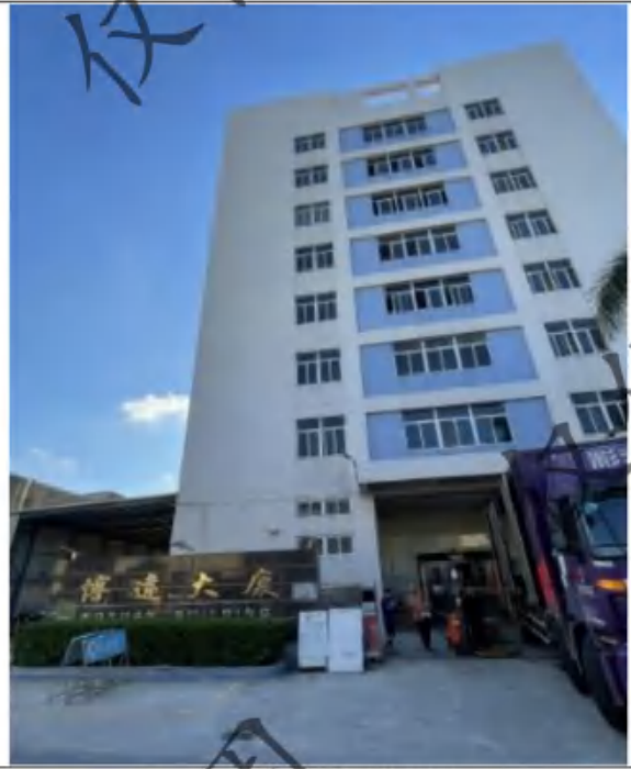
项目南面 博远大厦
