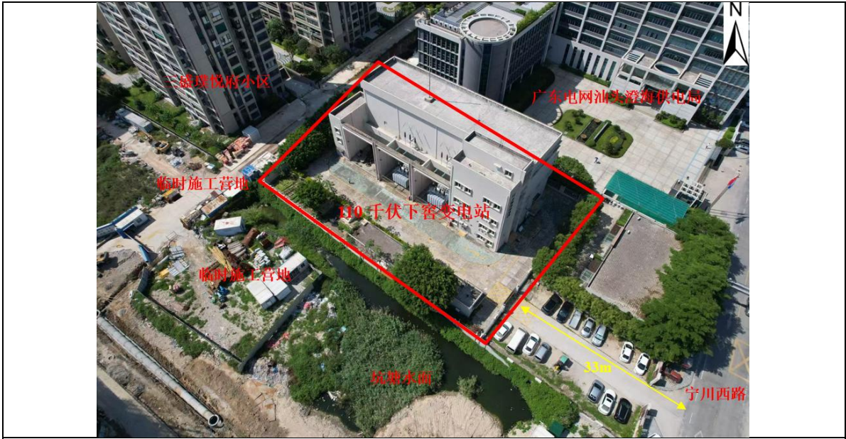
变电站站址现状
