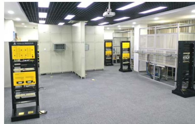
综合布线实训室
