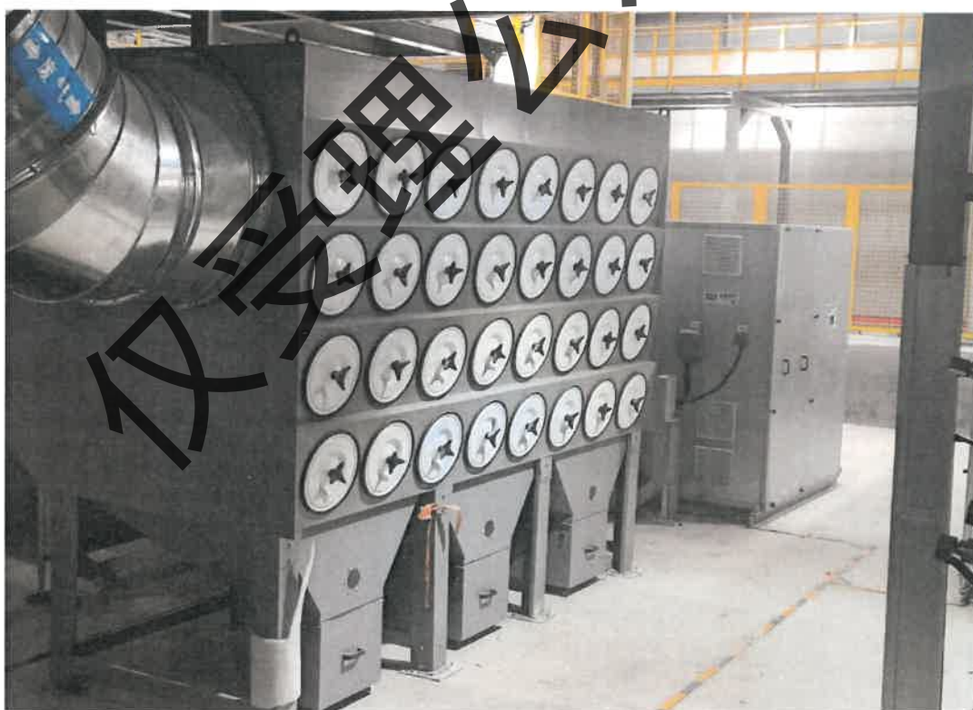
图 4.5 滤筒除尘器
