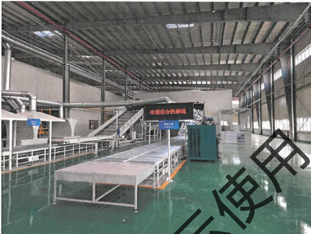
附图 2.5：废旧冰箱拆解处理线
