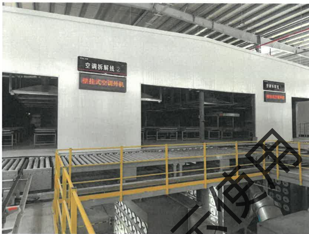
附图 2.4.1: 空调拆解线
