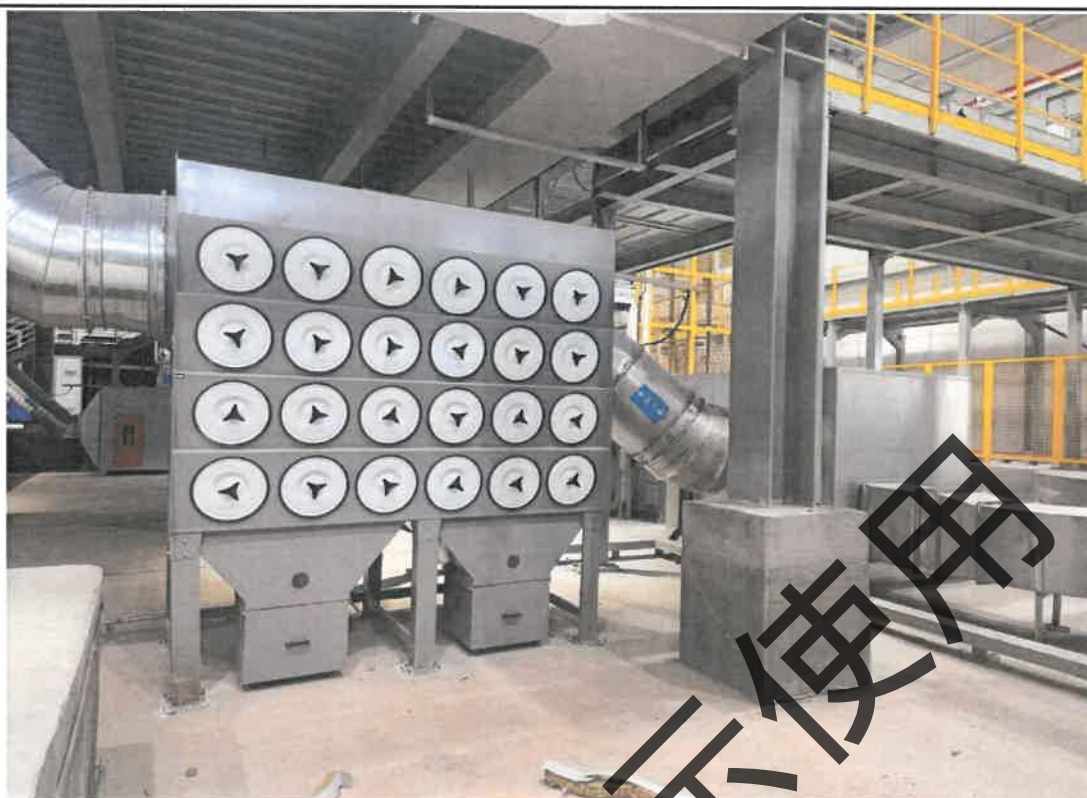
图 4.4 滤筒除尘器
