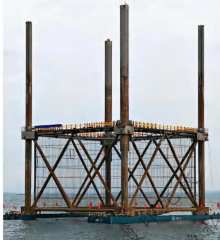
图 1.5.2-3 自升式桁架类网箱
